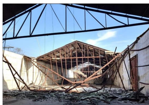
Figura 11: Vista interna do POA11 Fonte: ENGEPE Engenharia
